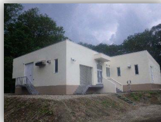
写真 6-3 勇振ポンプ場の耐震化
