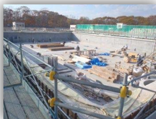
写真 6-2 緩速ろ過池の耐震化
